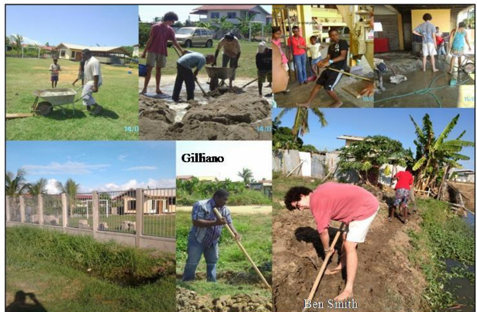
Indrukken van de bouw van de schutting
